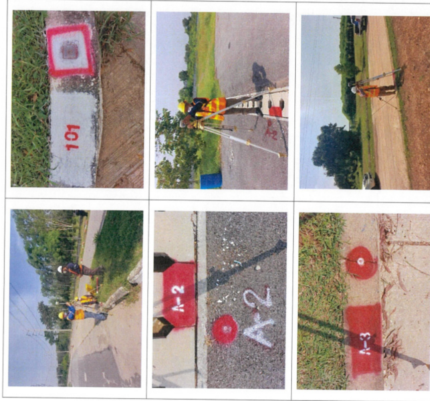
รูปที่ 3.6-1 รังวัดค่าพิภพหมดและค่าระดับของควบกลางของควมด้วยเครื่องวัดดาวเทียม GNSS
